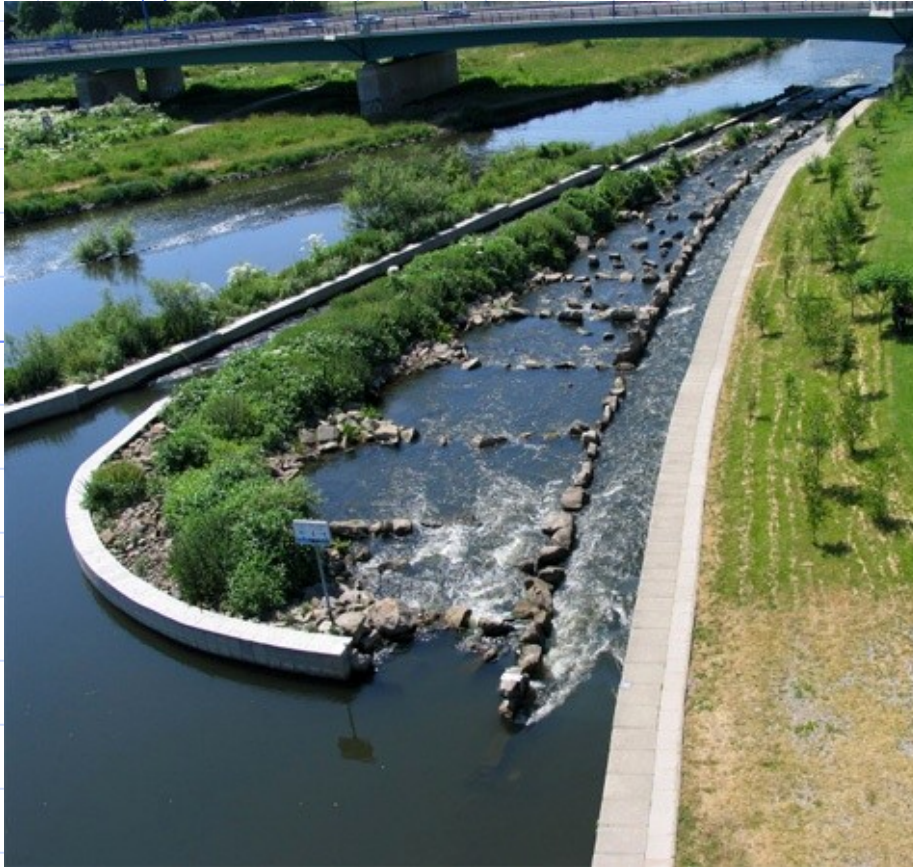
Kombibauwerk: Fischpass und Bootsgasse an der Ruhr in Hattingen (NRW)
