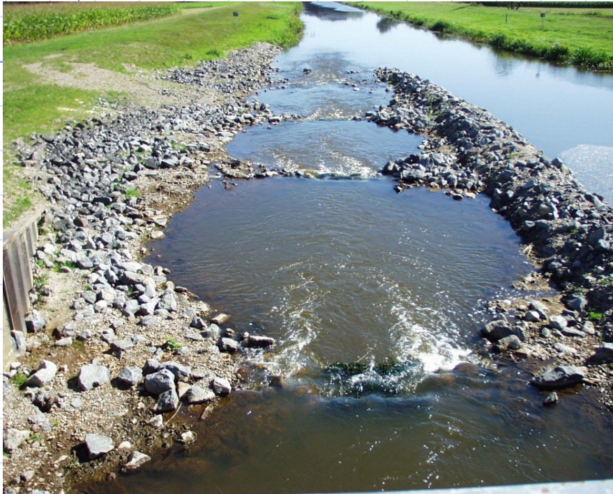
Tümpelpass mit Steinriegeln und Borsten in Hustedt an der Großen Aue (Niedersachsen)
