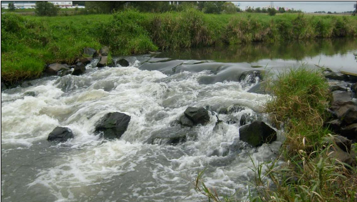
Raue Rampe von Unterwasser
