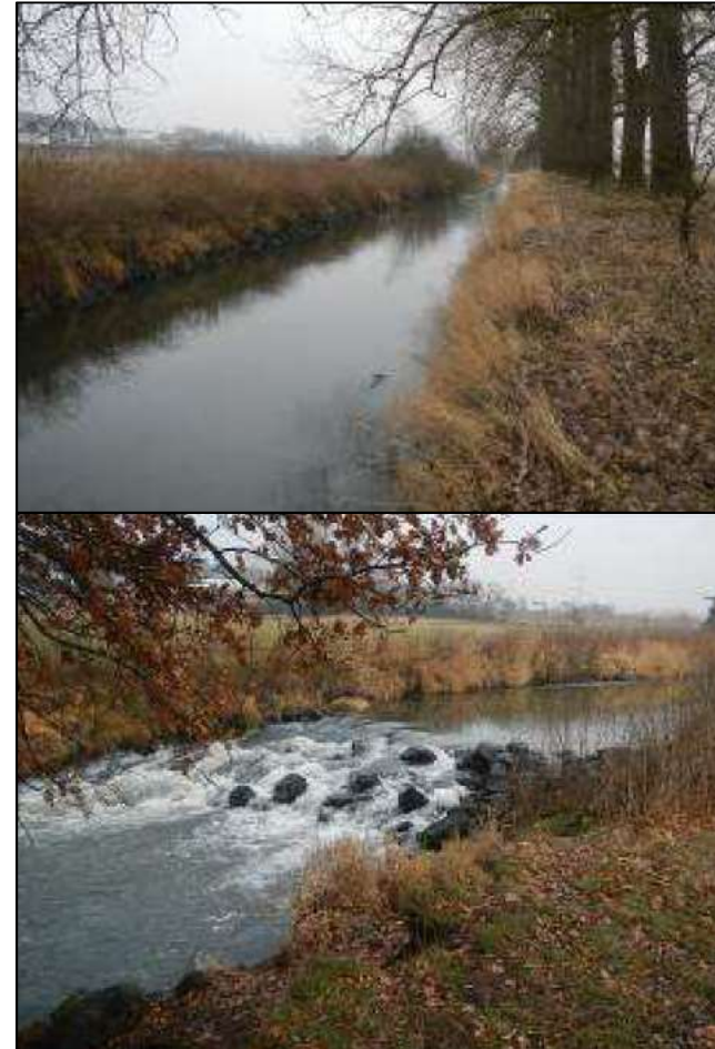
Ausgangszustand – geradliniger Gewässerlauf mit Wanderhindernissen
