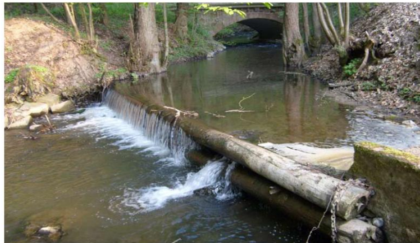
Abb. 21: Wanderhindernis an der Urff
