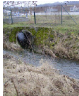
Ablauf der Kläranlage Marköbel [2/2009/Sommer]
