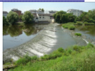
Fehlende flussaufwärts u. flussabwärts gerichtete Durchwanderbarkeit
