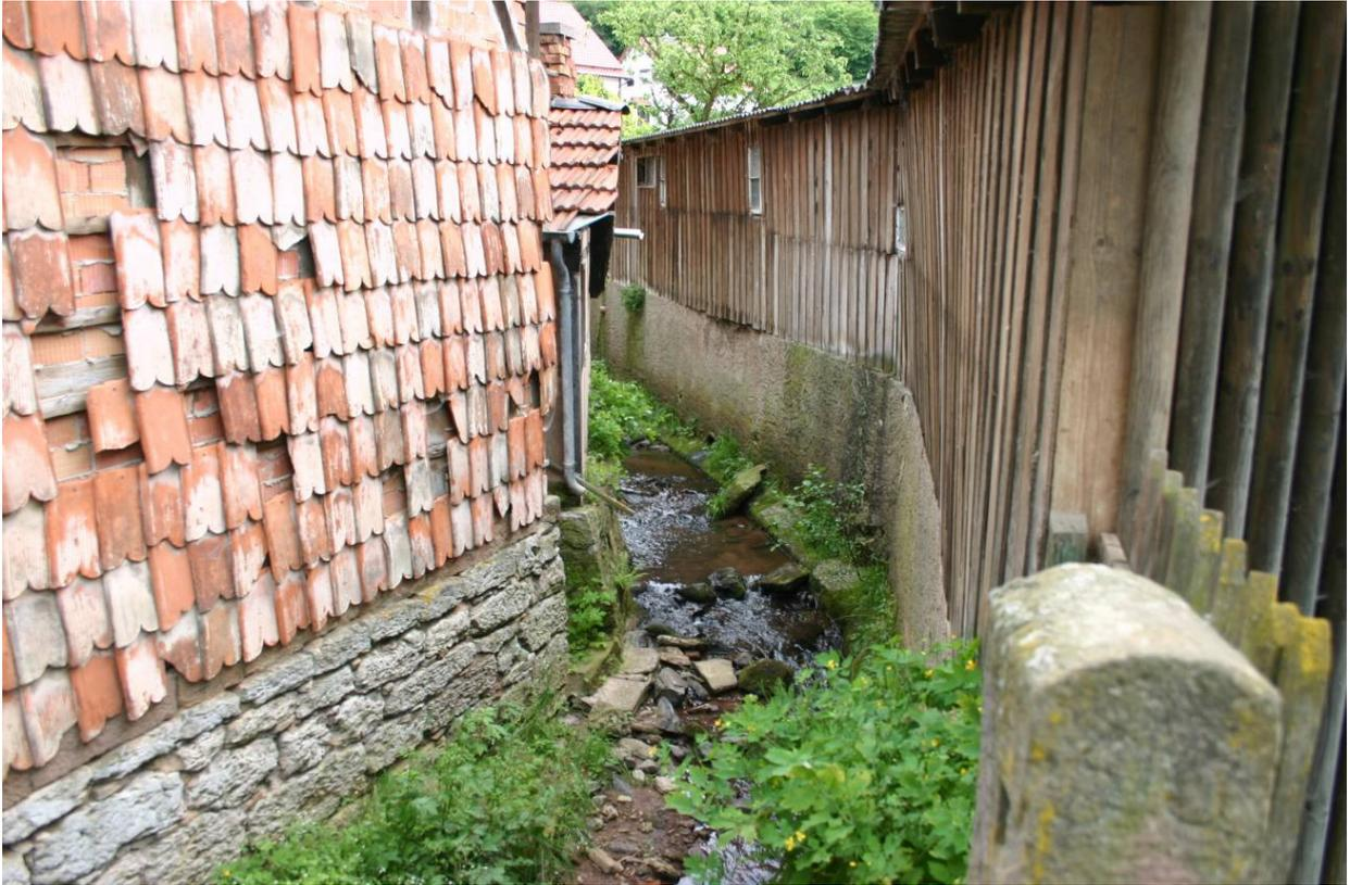
Abbildung 2: Wilhelmshäuser Bach in Roßbach zwischen Straßenraum und Gebäude. Die Sohle des Baches ist unversiegelt, das Gewässer linear durchgängig. Eine weitergehende strukturelle Aufwertung ist ohne Eingriff in den Gebäudebestand nicht möglich.
