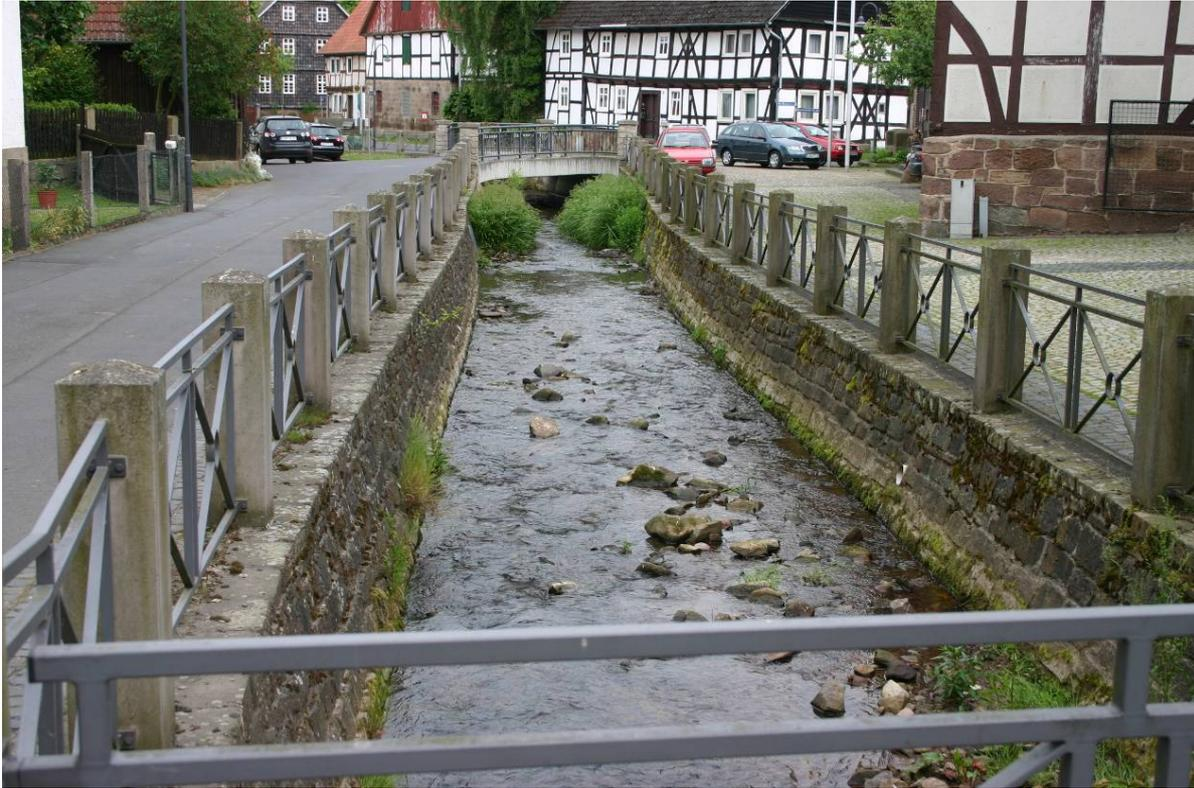
Abbildung 7: Rautenbach in Blickershausen, etwa Bach-km 0,3. Die Sohle des Baches wurde im Rahmen der Dorferneuerung entsiegelt und die lineare Durchgängigkeit wurde hergestellt. Weitergehende Renaturierungsmaßnahmen sind auf Grund der beengten Lage zwischen Straßenräumen unter Beachtung einer effizienten Verwendung der zur Verfügung stehenden Finanzmittel nicht möglich.
