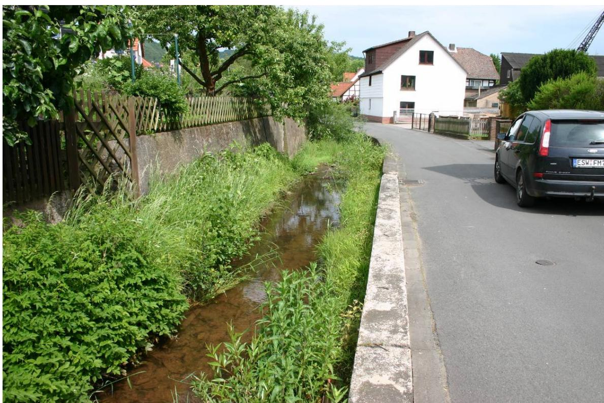
Abbildung 3: Hungershäuser Bach in Ermschwerd. Die Sohle des Baches ist unversiegelt; das Gewässer ist linear durchgängig. Eine weitergehende Renaturierung des Gewässers wäre – ein Einverständnis der Anlieger vorausgesetzt - allenfalls mit sehr hohem finanziellen Aufwand möglich (Rückversetzung der linksseitigen Mauer, teilweiser Erwerb von privaten Hausgärten).
