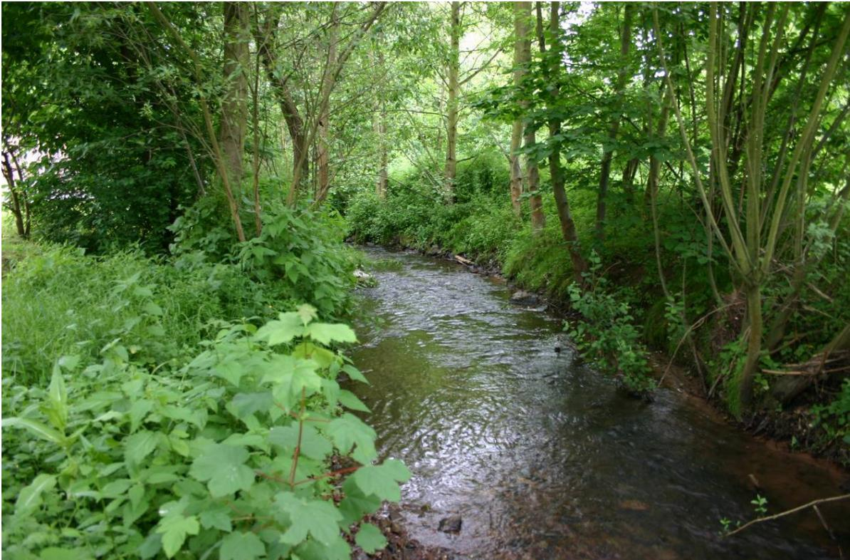
Abbildung 8: Rautenbach in Blickershausen, etwa Bach-km 0,1. Der Bach wurde aus einer straßenparallelen Lage in eine Wiesenfläche verlegt. Ufermauern wurden entfernt und die Versiegelung der Sohle aufgehoben. Der Bach weist heute eine naturnah strukturierte Sohle auf.
