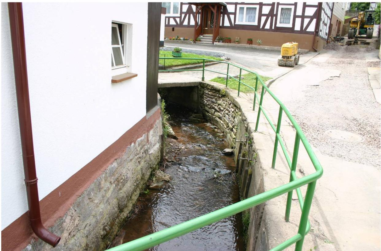
Abbildung 1: Wilhelmshäuser Bach in Roßbach zwischen Straßenraum und Gebäude. Die Sohle des Baches ist unversiegelt, das Gewässer linear durchgängig. Eine weitergehende strukturelle Aufwertung ist ohne Eingriff in den Gebäudebestand oder den Straßenraum nicht möglich.
