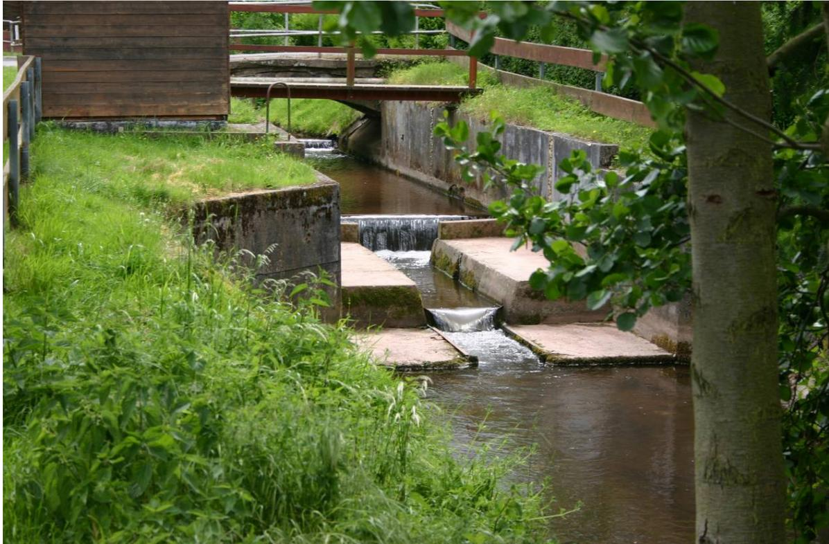
Abbildung 10: Die Pegelanlage des RP Kassel in Ziegenhagen unterbricht die biologische Durchgängigkeit des Rautenbaches fast vollständig.
