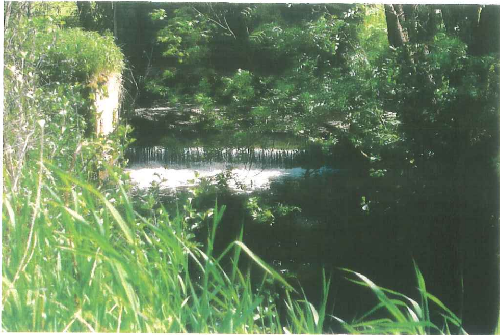
Bild 3: Absturzbauwerk an der Elbe bei Fluss-km 1,2
