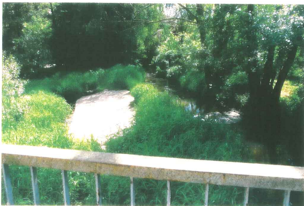
Bild 4: Absturzbauwerk (Wehranlage) an der Elbe bei Fluss-km 2,1. Eine Aufstiegseinrichtung ist nicht vorhanden.
