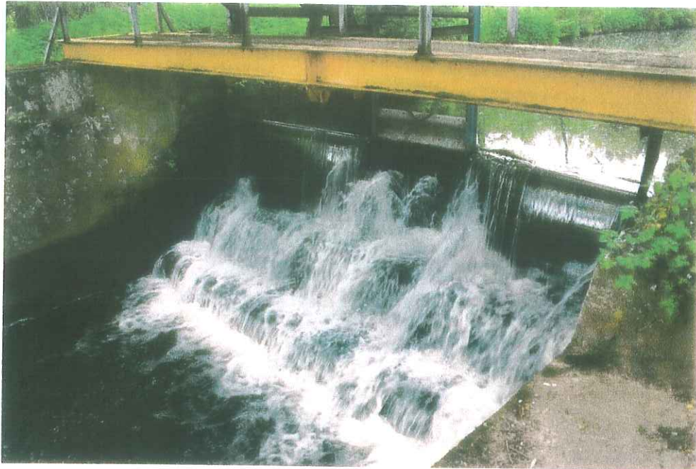
Bild 7: Für Fließgewässerorganismen nicht passierbare Wehranlage an der Elbe bei etwa Fluss-km 5,9
