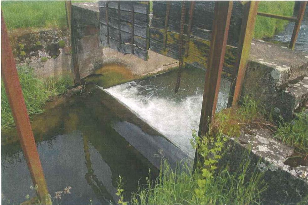
**Bild 3:** Sontra, km 5,2. Die vermutlich ehemals der Bewässerung dienende Wehranlage bei Fluss-km 5,2 ist heute allenfalls eingeschränkt funktionsfähig. Sie unterbricht die lineare Durchgängigkeit für die meisten Fischarten und das Makrozoobenthos.
