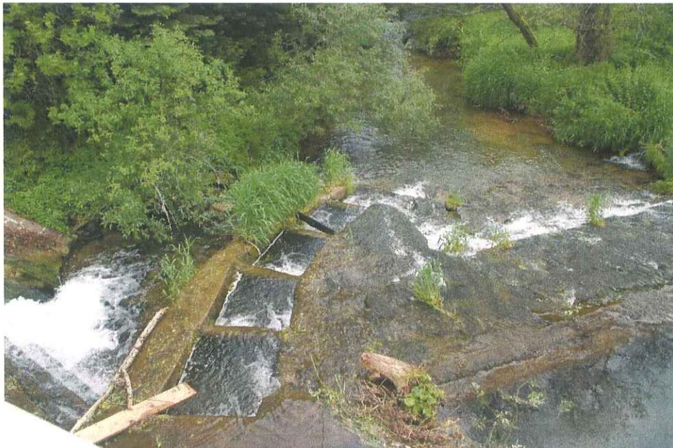
Bild 2: Sontra, km 4,3. Die Wehranlage bei Fluss-km 4,3 ist mit einer Fischtreppe ausgerüstet, die jedoch nur eine eingeschränkte Funktionsfähigkeit aufweist. Auch hier ist die lineare Durchgängigkeit weitgehend unterbrochen.
