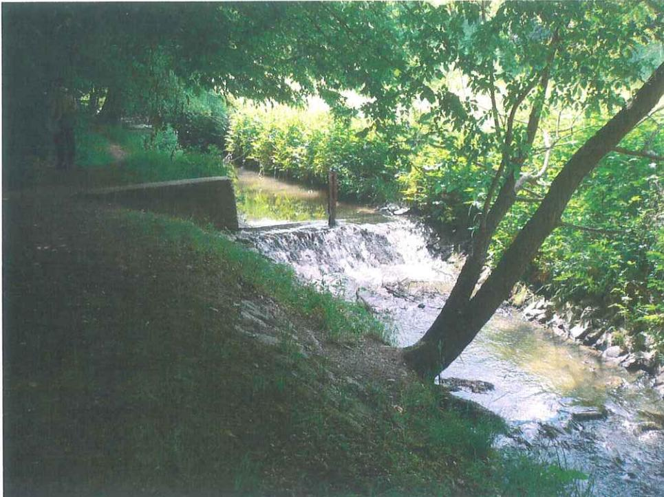
Umbau des Wehr als raue Sohlrampe entsprechend der hydraulischen Erfordernissen möglich. Bei Einer Absturzhöhe von 60 cm errechnet sich die Länge entsprechend der Neigung 1:12 und Kosten zu 15.000 €.
