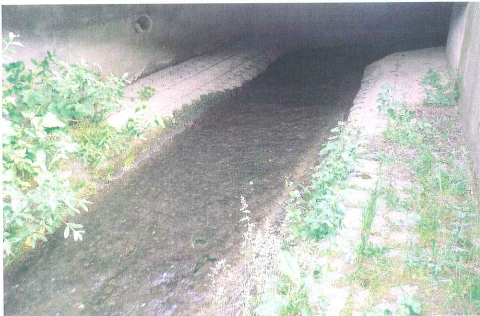
Ein Wanderungshinderniß 58346 (Maßnahmen ID) für Fische ist nicht gegeben. Der Massivsohlenabschnitt zur Sicherung der Flügelmauer der B 275 kann nicht entfernt werden. Da der befestigte Streckenabschnitt nur kurz ist, kann angenommen werden, dass keine nachteiligen Auswirkungen auf den Benthos vorliegt. Zur zusätzlichen Ansiedlung von Sohlsubstrat soll im Sohlbereich eine Drahtmatte aufgedübelt werden.
