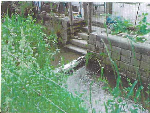
Abb. 13: Uferverbau mit Treppen und Sohlschwellen
