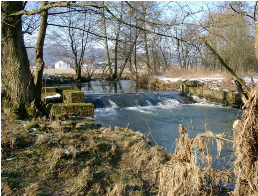
Querbauwerk an der Kinzig
