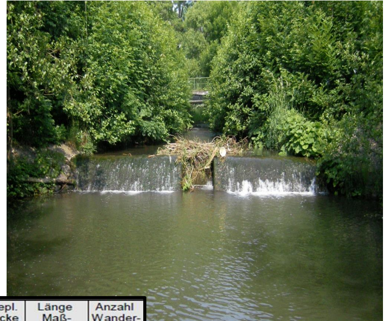
Einstiegswehr Ulmbach – Absturzhöhe ca. 1, 20 m plus Tosbecken
