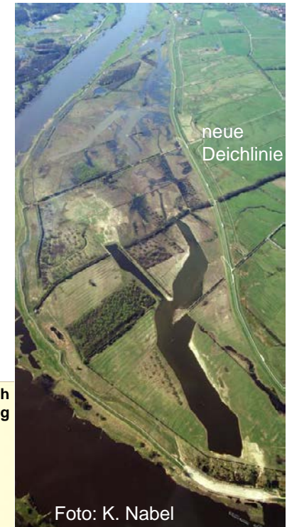
nach Umsetzung der Maßnahme (2011)
