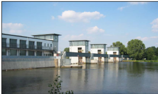
Abb. 4.7.1: Wasserkraftanlage und Wehr von Oberwasser
