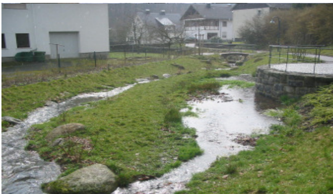
Strukturelle Aufwertung von Gewässersohle und Uferbereichen unter Berücksichtigung der lokalen Restriktionen. Aufgrund der Restriktionslage eigendynamische Entwicklung von Sohle/Ufer nicht bzw. nur stark eingeschränkt möglich. Ziel: Vernetzung mit ober- bzw. unterhalb liegenden Gewässerabschnitten.
