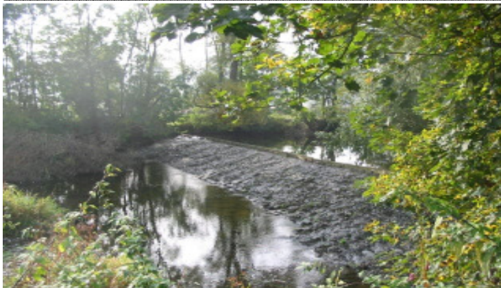
Erhöhung der Mindestwasserführung: Angleichung an die gewässertypischen Verhältnisse Absenkung des Stauzieles
