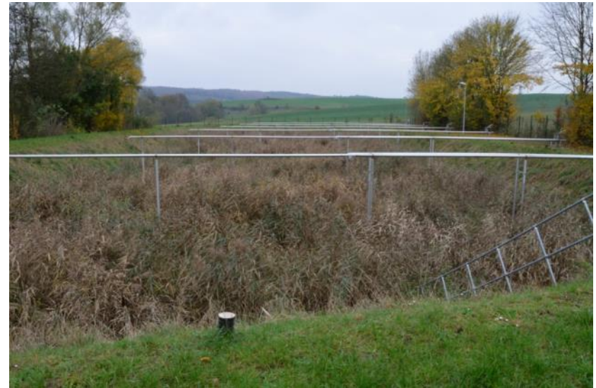
Klärschlammvererdung am 7 Nov. 2014
