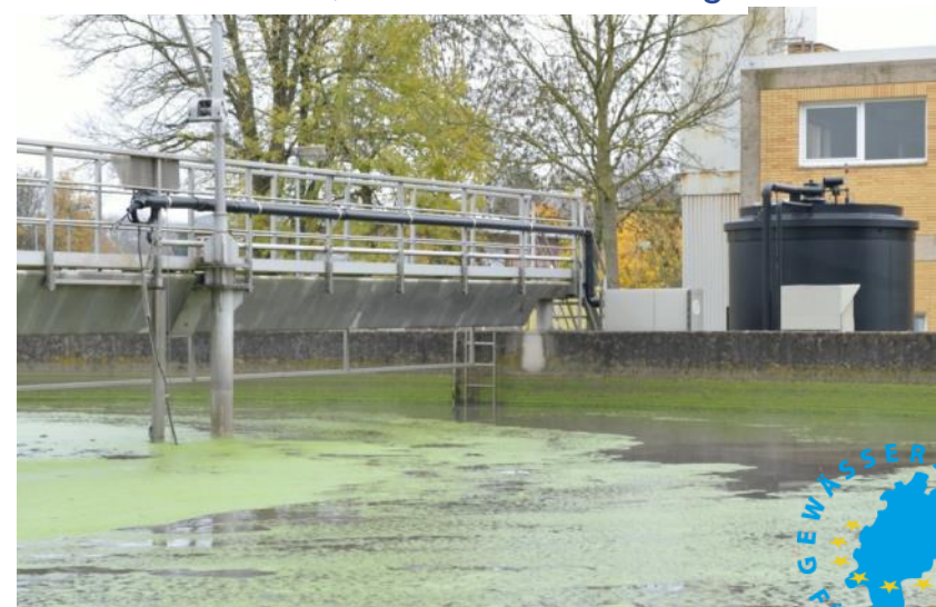
Anaerobbecken , Bio-P und P-Fällung
