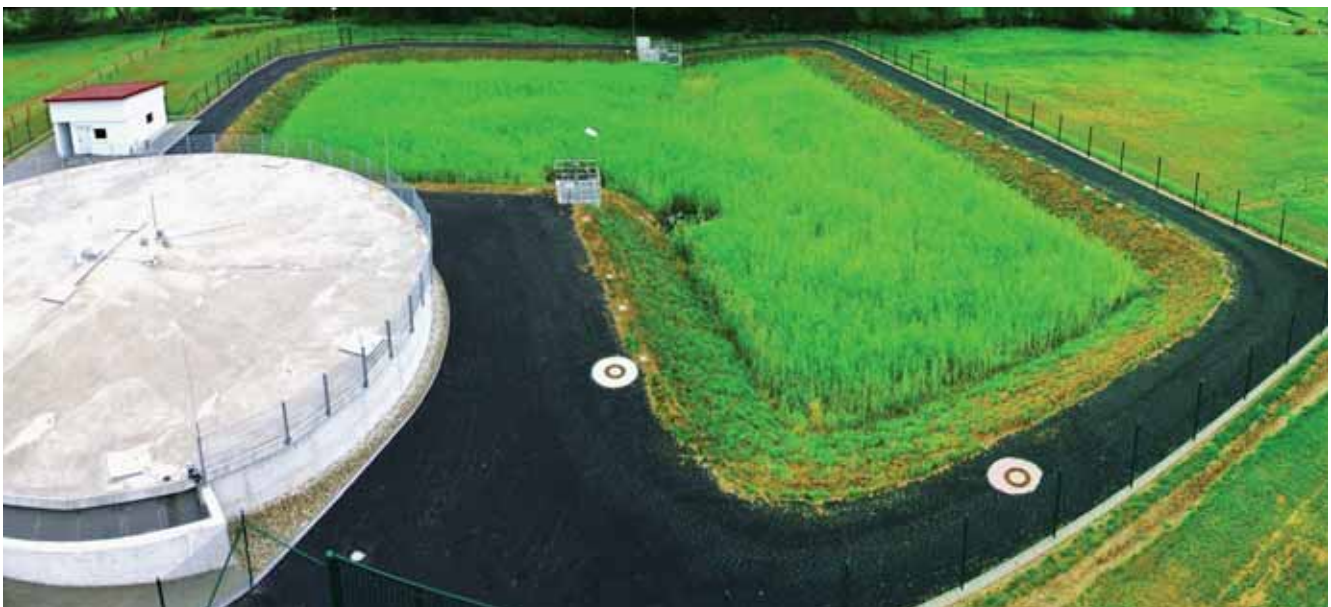
Abb. 27: Retentionsbodenfilter mit Durchlaufbecken an der Oberen Kinzig
