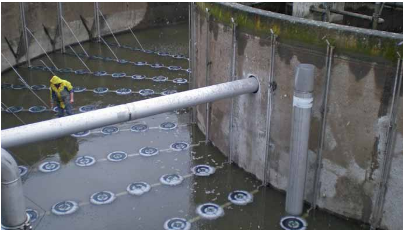
Abb. 25: Umrüstung der Kläranlage „Hüttengesäß“
