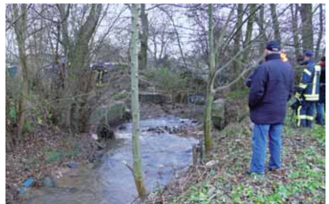
Abb. 13: Wickerbach nach der Wehrsprengung
