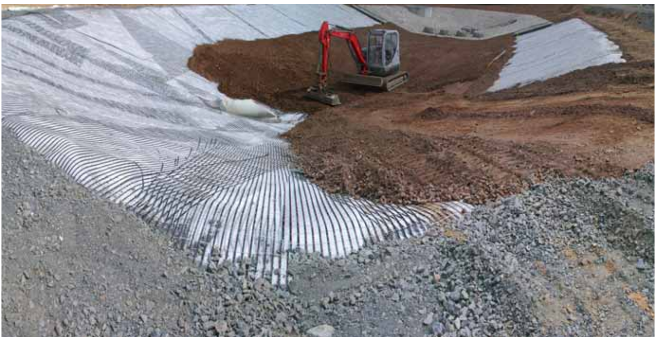
Abb. 28: Retentionsbecken im Bau am Rodenbach
