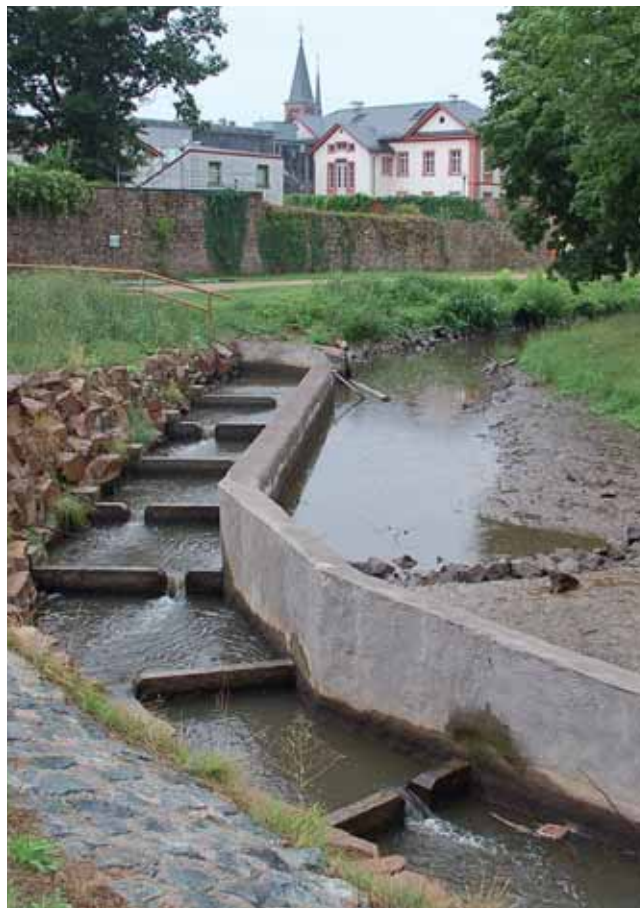
Abb. 8: Fischaufstiegsanlage an Amtsgerichtsrampe
