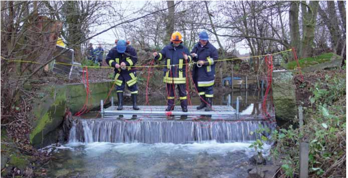
Abb. 11: Vorbereitung der Sprengung
