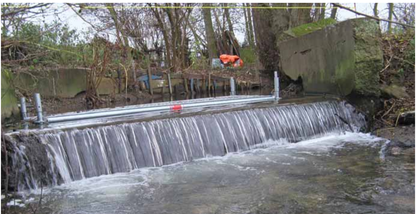
Abb. 10: Sohlabsturz am Wickerbach (Hochheim/Main)
